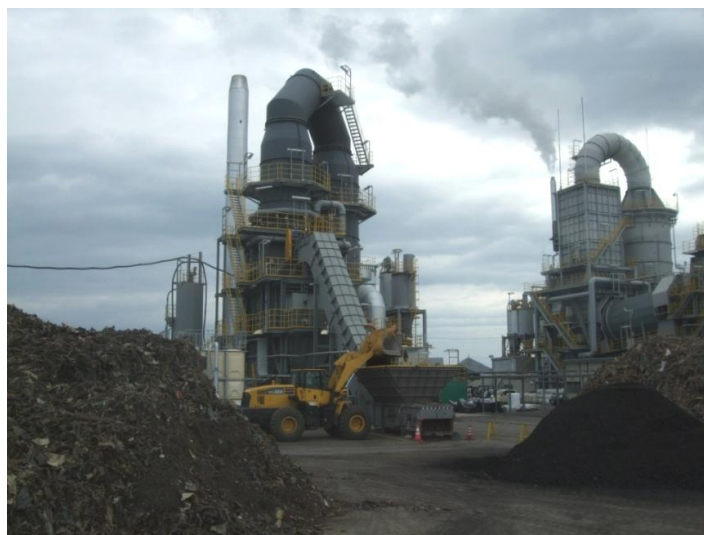
写真 2. 仮設焼却炉（相馬市）。
