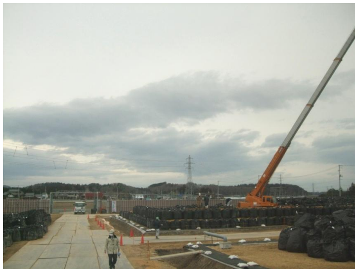
写真3. 除染仮置場（南相馬市）。
