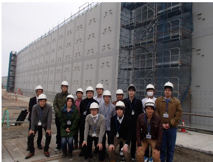
津波対策工事の様子
